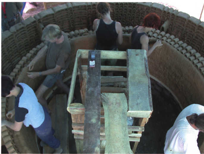
Construcción de la obra "Verwandlungskreis". Berlín, 2002. "Verwandlungskreis" under construction. 2002, Berlin.
