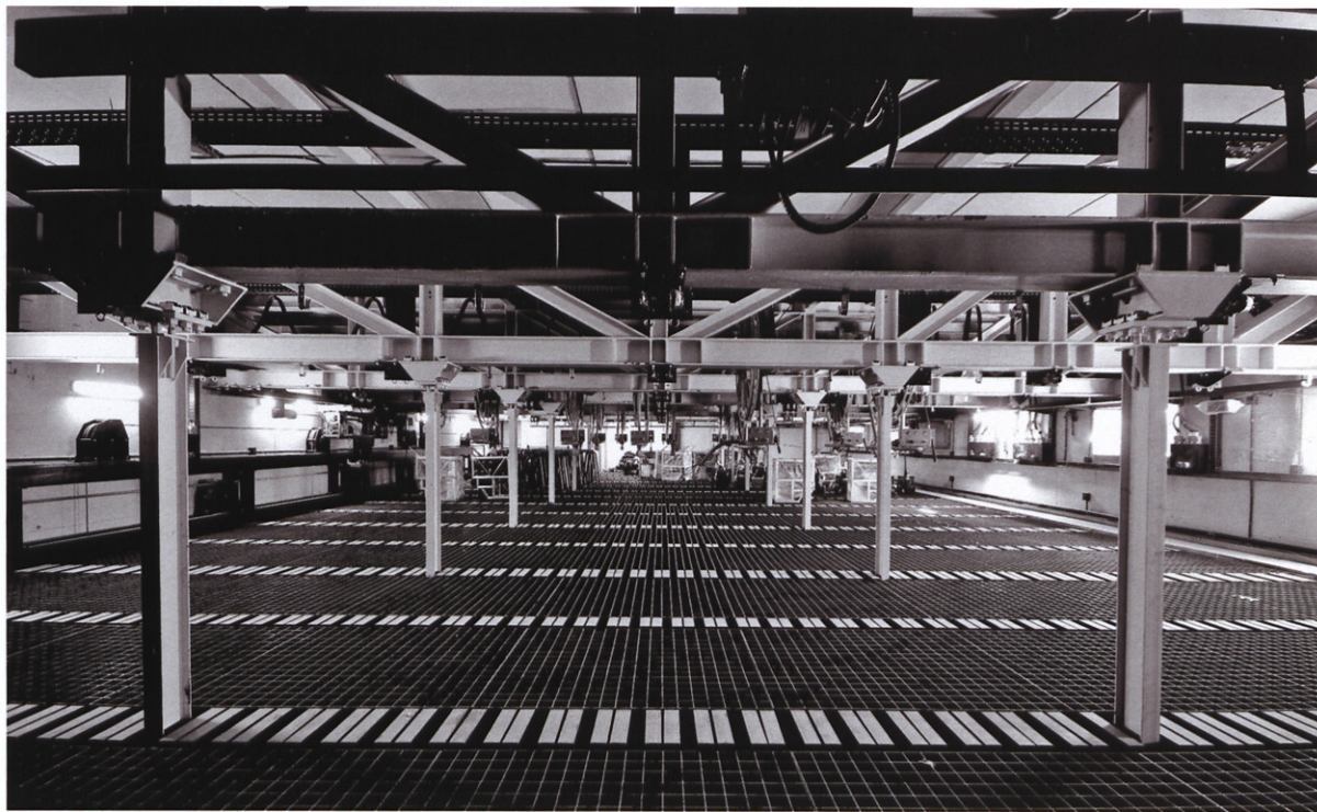
Graderío, estructura y equipamiento técnico de una de las salas. Steps, structure and technical equipment of one of the theaters.
