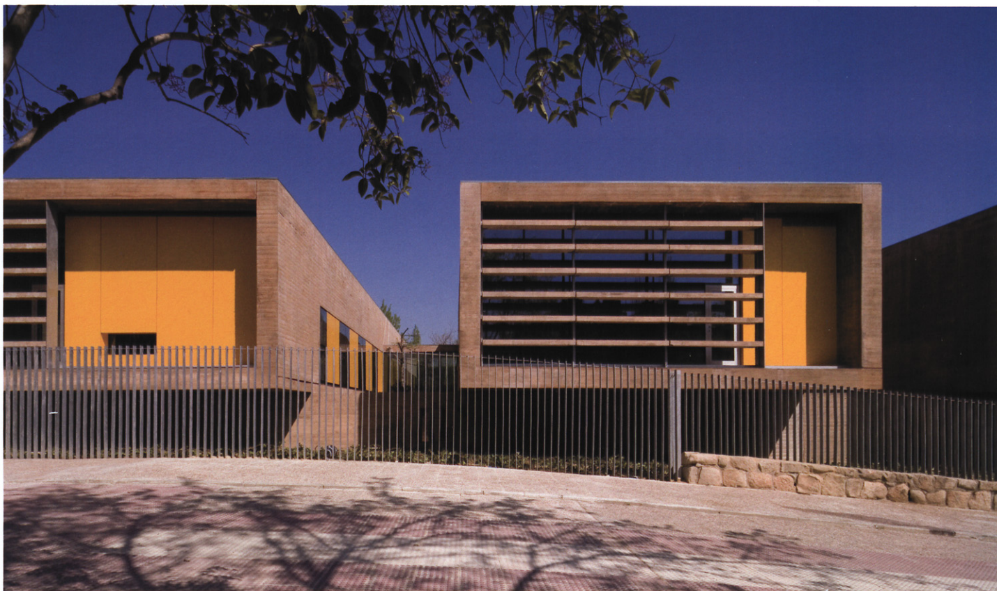
Los prismas de hormigón asomando hacia el parque en el extremo sur. The concret prisms face the park in the south.
