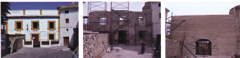
Proceso constructivo del pósito. Posito's constructive process.
