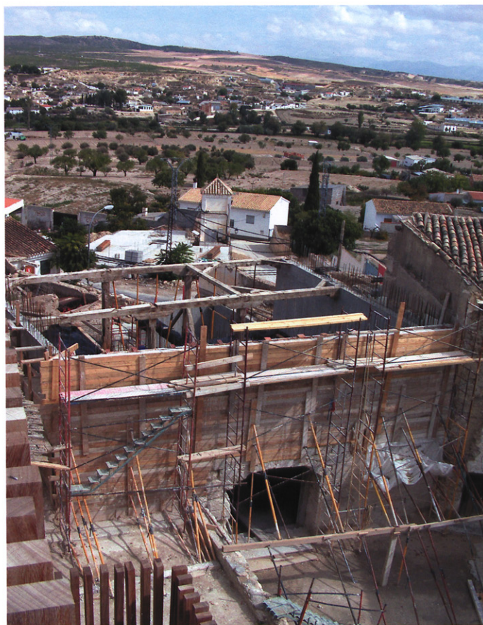
Encofrado del muro de acceso. Plank mould of the entrance.
