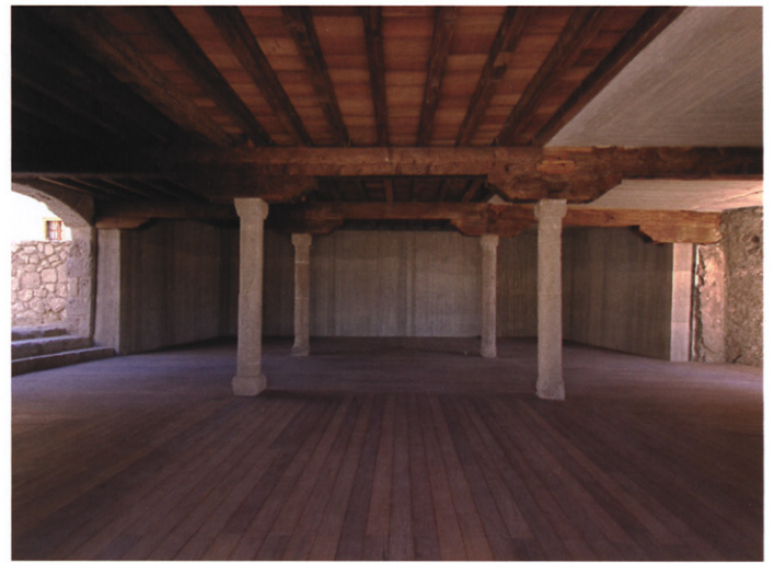
Estructura interior original, en torno a cuatro columnas y a una serie de pilares adosados a los muros, sobre los que descansa la armadura de colañas que soporta el forjado. Original structure with four main columns and some pillars fixed to the walls.
