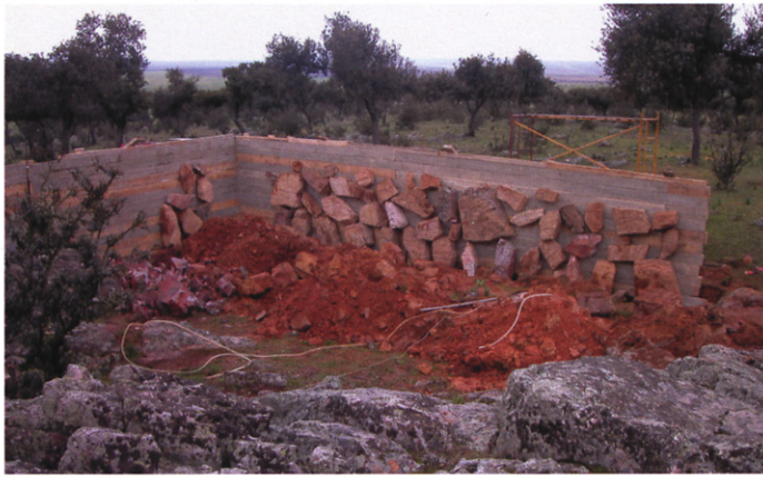
Muros de hormigón ciclópeo. Cyclopean concrete walls.
