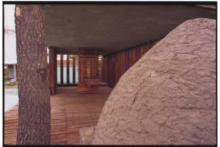
El tronco de madera, en estado natural, hace las funciones de pilar. Junto a él, el horno de barro y, al fondo, la mesa, el tercer y último elemento en la quincha.
