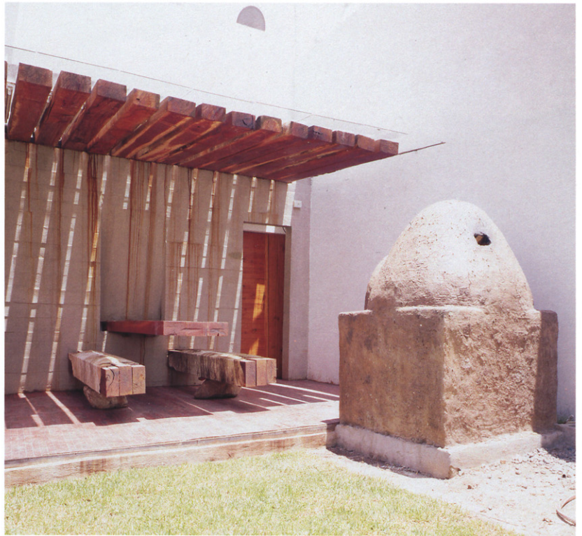
El quincho consiste en una L de hormigón armado que forma tanto el suelo como el muro. A este paramento vertical se empotran los demás elementos. The quincho consists of a reinforced concrete L that forms a floor and a wall. The rest of the elements (the grill, the tables and the benches) are clamped, fixed and levelled to it.
