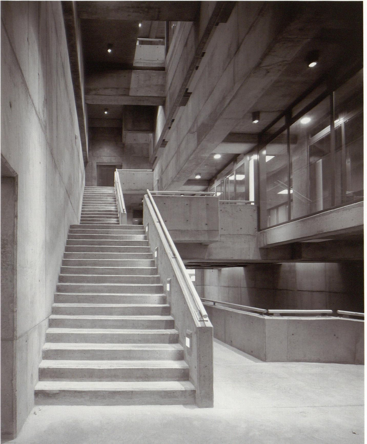
Vista, desde el acceso, de la estructura de hormigón *in situ* del núcleo de comunicación.
