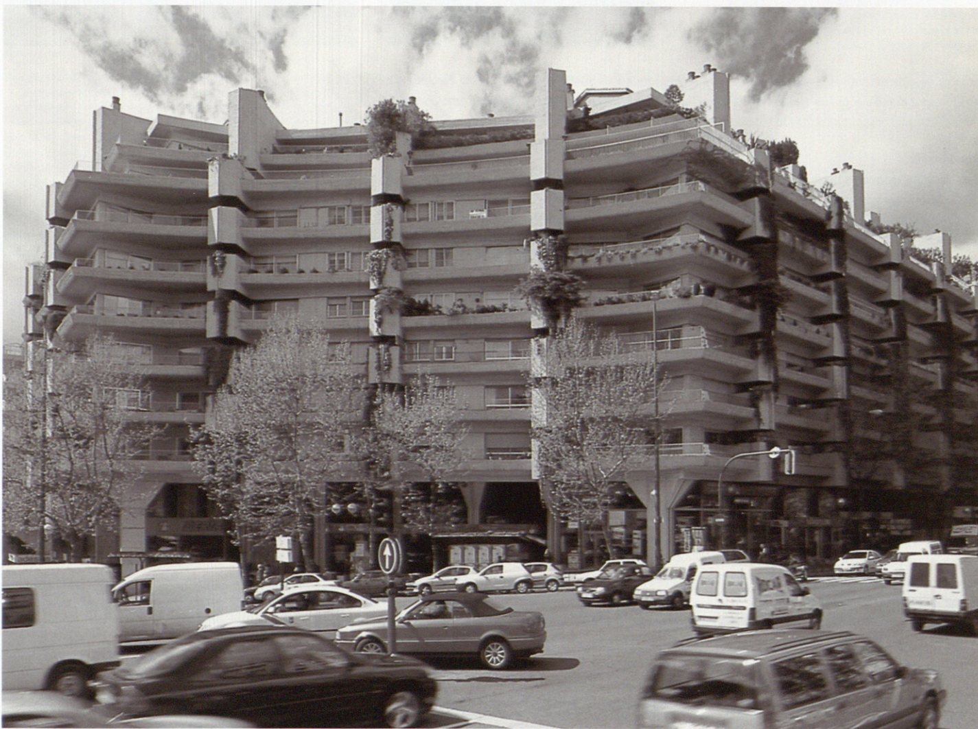
Las jardineras dan privacidad y frescor a las viviendas que, gracias a las terrazas, no sufren el sol vertical del verano. The gardens provides the houses privacy and freshness, thanks to the terraces, they don't suffer the vertical sun of the summer.
