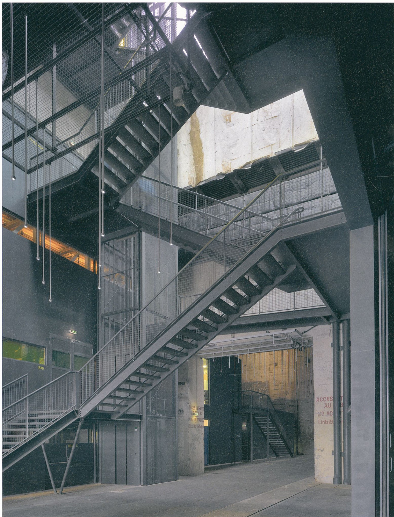
Detalle de iluminación en el acceso a la zona subterránea. Lighting detail in the entrance of the underground area.
