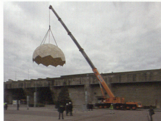
Traslado a la cubierta del búnker en Saint-Nazaire. Moving it to the bunker's roof.
