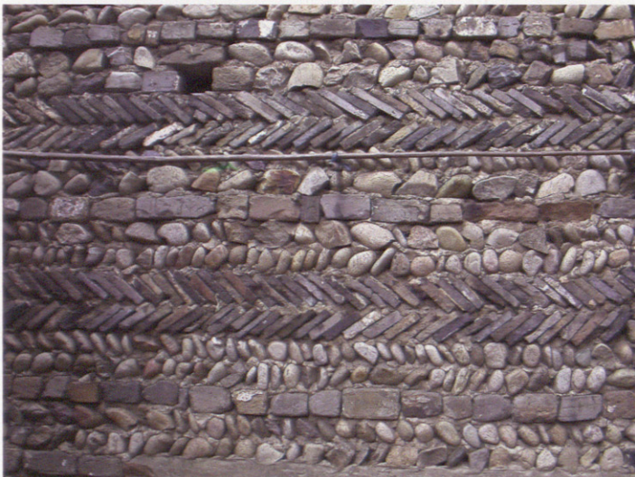
El antiguo pueblo de Long Men, junto a Hangzhou. Uso tradicional de la mampostería mixta, prácticamente sin mortero. The old village of Long Men, by Hangzhou. Traditional use of mix masonry, with hardly any mortar.
