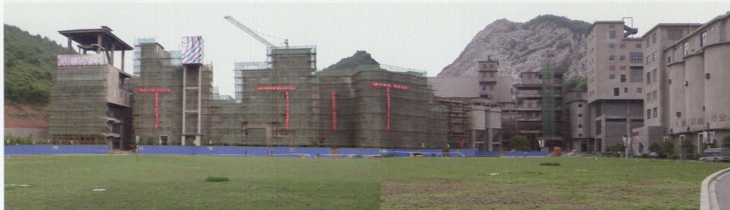
Obras de transformación de la antigua fábrica de cemento Shuangliu en el Phoenix Creative International Center, recientemente inaugurado como parque para empresas de la industria creativa.
