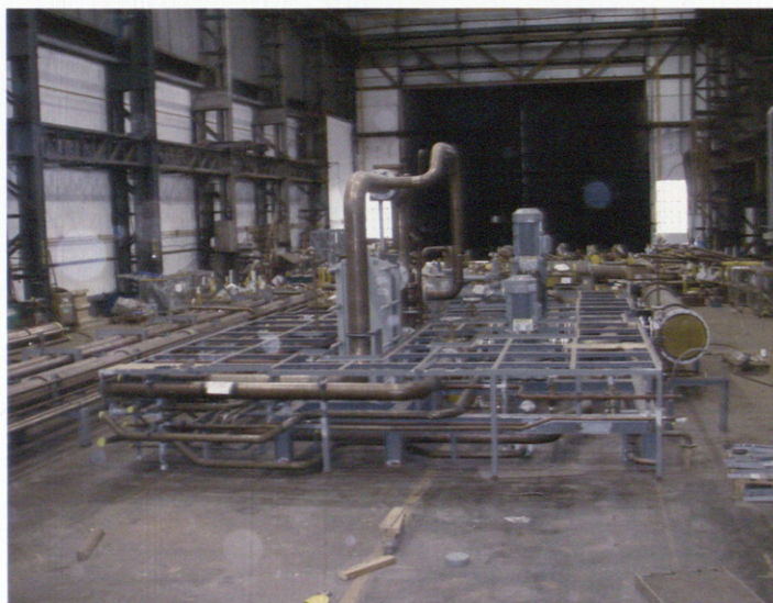
Distintas fases del montaje sobre la playa tras la prefabricación. Different phases of the assembly on the beach after the prefabrication.
