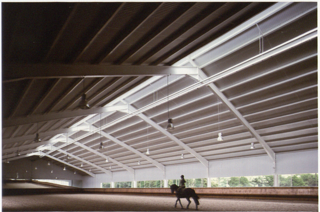
Arriba, detalle de carpinterías de los establos. Sobre estas líneas, la cercha de la pista de entrenamiento. At the top, details of the carpentries of the stables. Above these lines, the training track truss.
