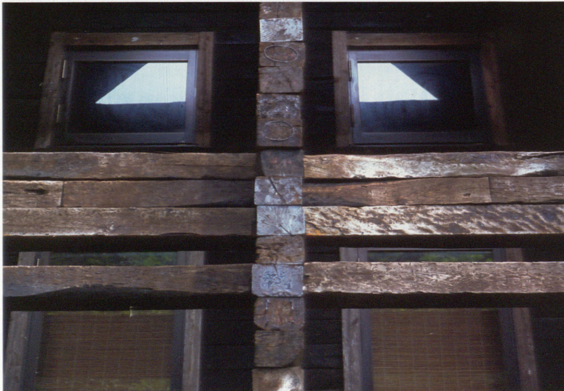
De izqda. a dcha. y de arriba abajo. Estructura de hormigón debajo de la superestructura de la construcción de troncos. Vista del testero sobre el lado del valle. Las traviesas insertadas y voladas desde la chimenea proporcionan estabilidad. From left to right and from above to below. The concrete substructure beneath the log construction superstructure. View of gable facade on valley side. Sleepers inserted into and cantilevering from the projecting stack provide stability.
