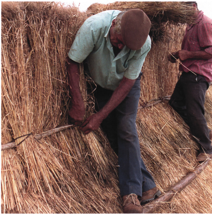
Materiales y modos de construcción. De izquierda a derecha, proceso de colocación de una cubierta tradicional de paja. Abajo, usos en pavimentos paredes, chimeneas, puertas, techos y ventanas. Materials and construction methods. From left to right, the process of placing a traditional thatched roof. Below, uses in pavements, walls, fireplaces, doors, roofs and windows.
