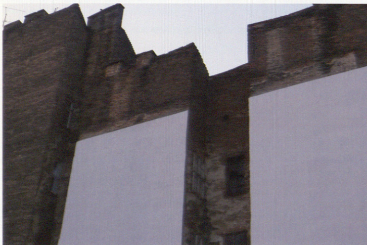
De arriba abajo, edificio en la calle Vadasz, Centro de transformación en la calle Dob y medianeras en la calle Pumbach Sebestyen. Top-down, building in Vadasz street, Transformer Station in Dob street and dividing walls in Pumbach Sebestyen street.
