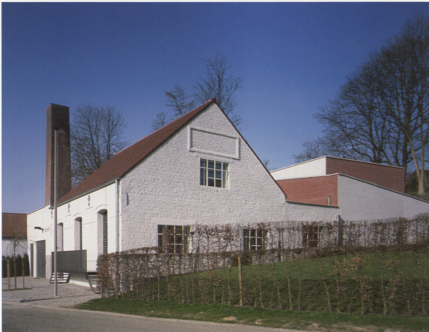
El edificio original, de fachadas blanqueadas, alberga las estancias para los músicos. The original building, with white walls, holds the rooms for the musicians.
