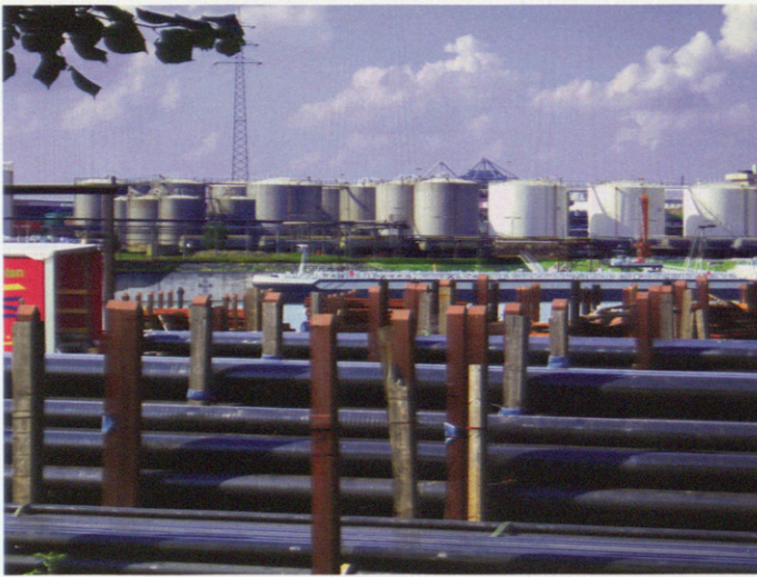
Depósitos de almacenaje junto al río. Containers next to the river.
