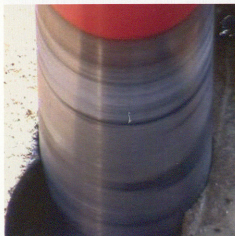
Imágenes de las brocas cilíndricas perforando las bóvedas de los aljibes. Images of the cylindrical bits drilling the cisterns' vaults.
