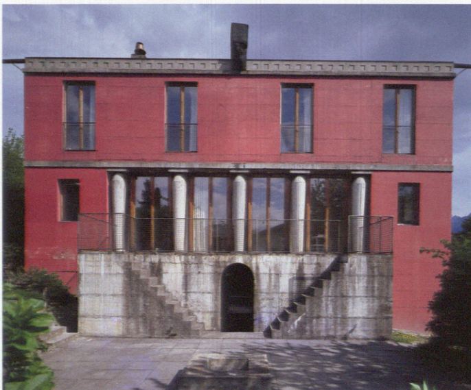
A la izqda., la aparente arbitrariedad, la torpeza controlada, a la hora de abrir huecos en la fachada lateral. Left, the apparent arbitrariness, the clumsiness under control, when opening windows in the side façade.
