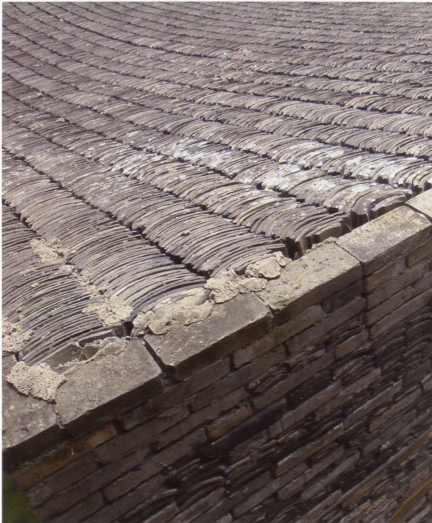
Encuentro entre muro y cubierta de uno de los edificios de la universidad. La teja es utilizada tanto en el aparejo del muro como en la cubierta. View of the meeting between the wall and the roof of one of the University buildings. The tiles are used in the wall bonding as well as on the roof.
