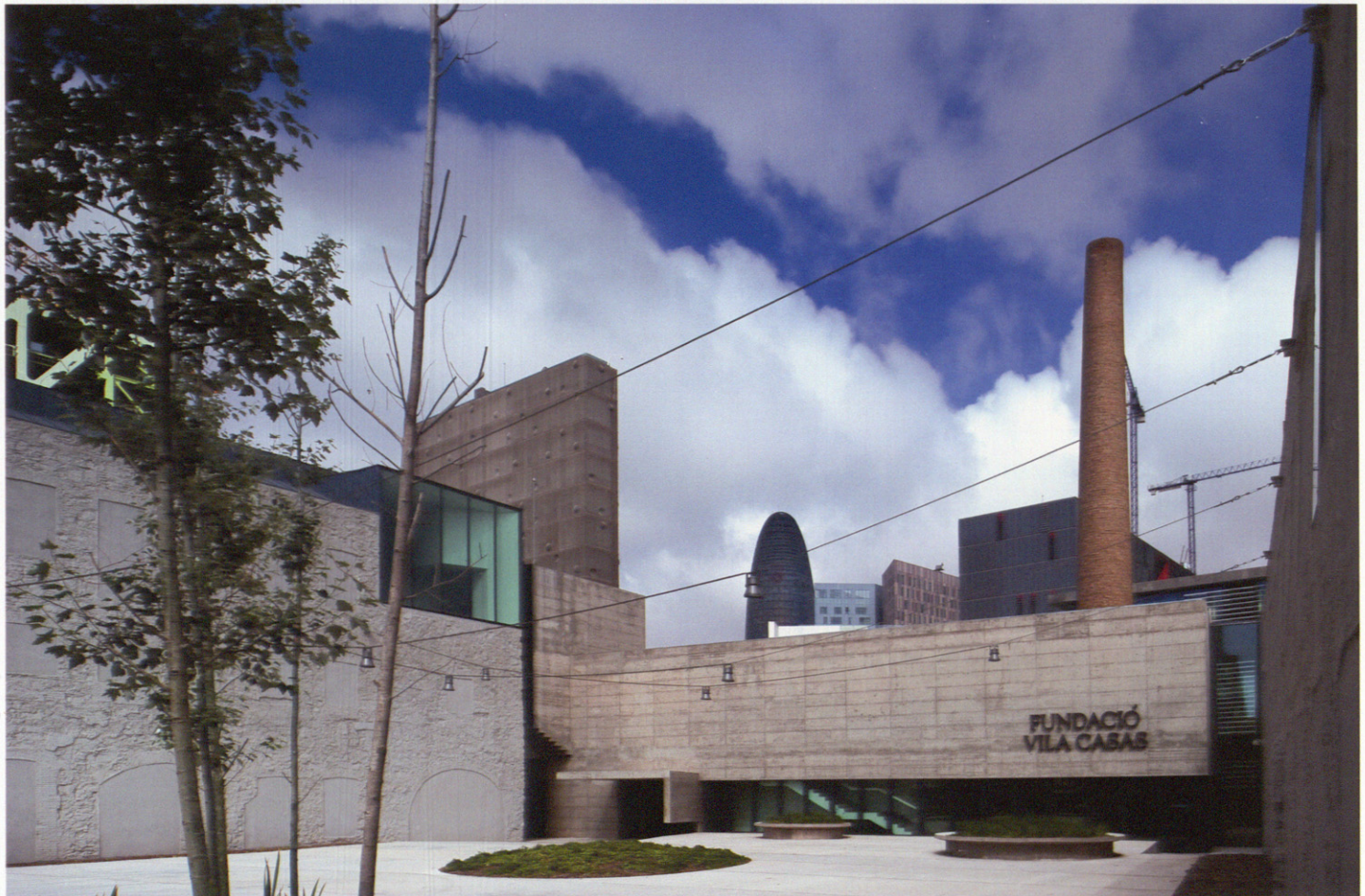
Encuentro entre la nave construida (zona de acceso) y los volúmenes pre-existentes. The meeting between the built warehouse (access area) and the pre-existing volumes.
