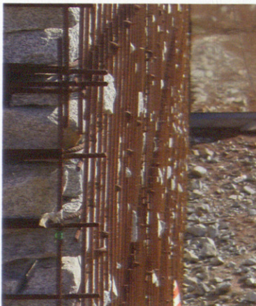
Gaviones que conforman el cerramiento del acceso al museo. Gabions that make up the closure of the museum access.
