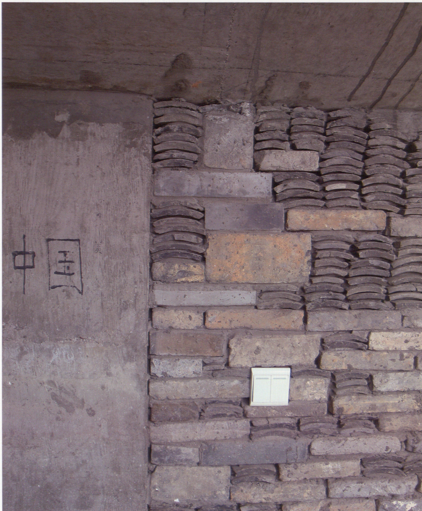
Detalle de aparejo en la universidad de XiangShan. Ladrillos y tejas de distintos periodos fueron reutilizados en la construcción. Detail of the bonding at the XiangShan University. Bricks and tiles from different periods were reused in the construction.
