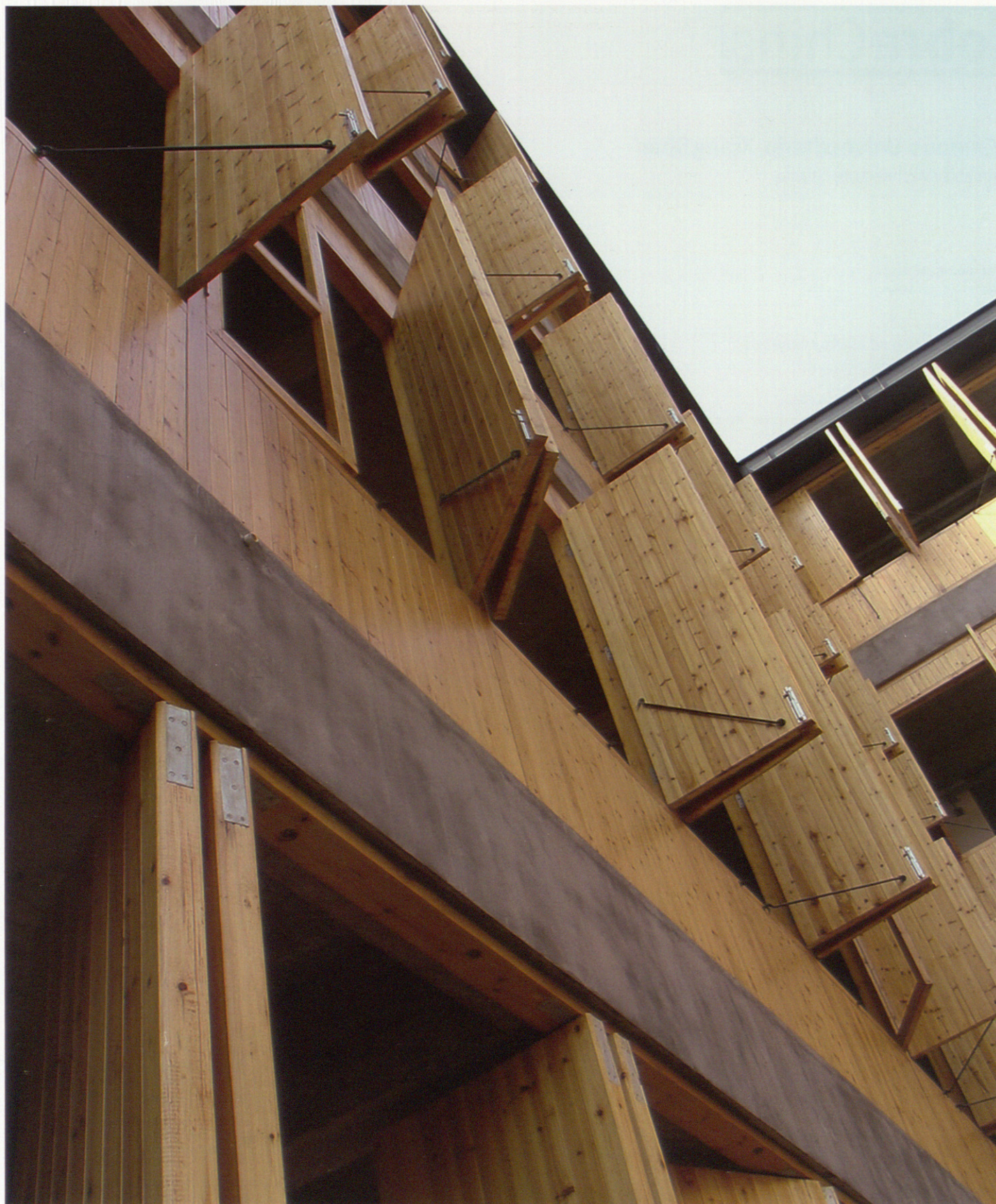
Empleo de madera en el edificio 4, aula de la Escuela de Cine. Detalle de la fachada de madera capaz de abrirse o cerrarse mediante elementos abatibles.
