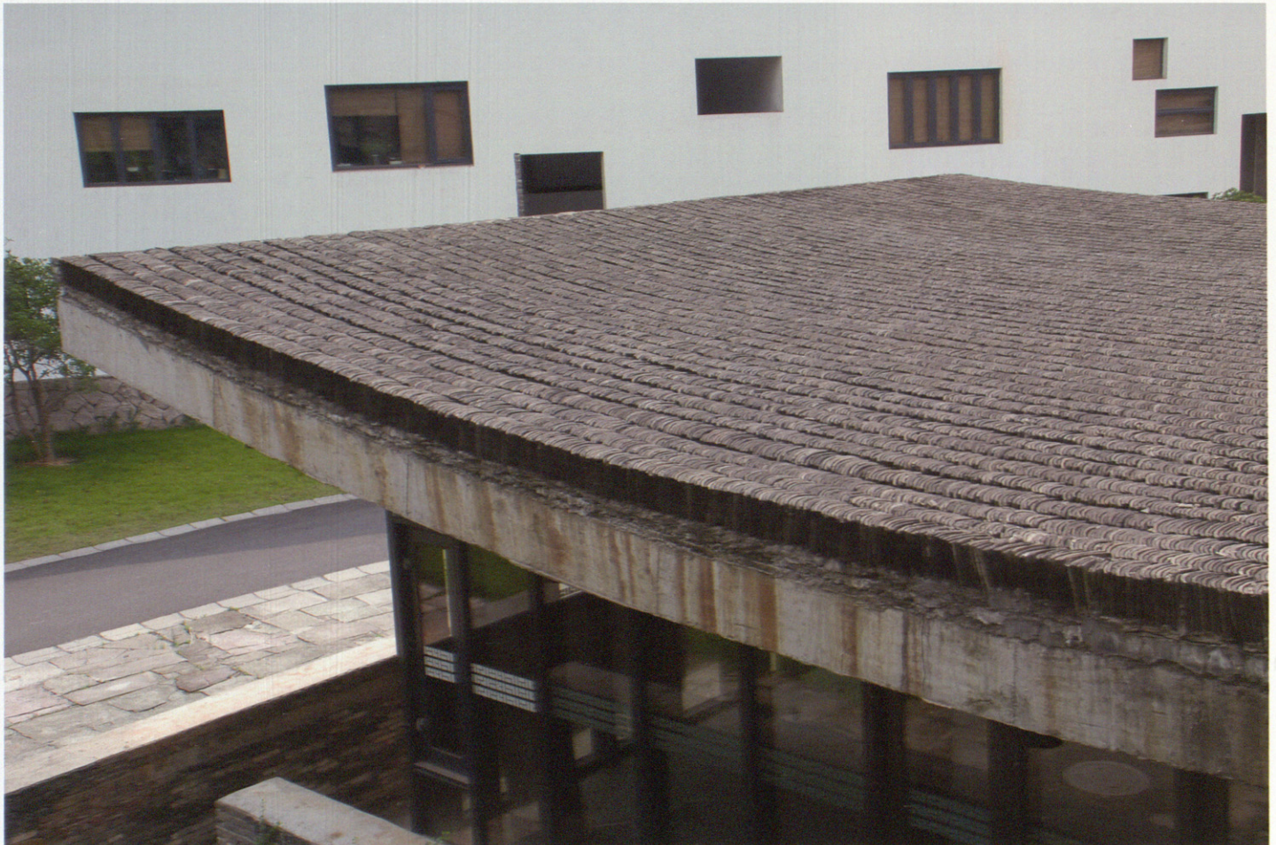
Una de las cubiertas de teja reutilizada de la universidad. La teja no tiene como función impermeabilizar sino que, colocada en posición vertical, oculta bajo ella un forjado de hormigón. View of one of the University roofs with reused tiles. The tiles don't have waterproofing as one of their functions but rather, arranged in a vertical position, they hide a concrete flooring under it.
