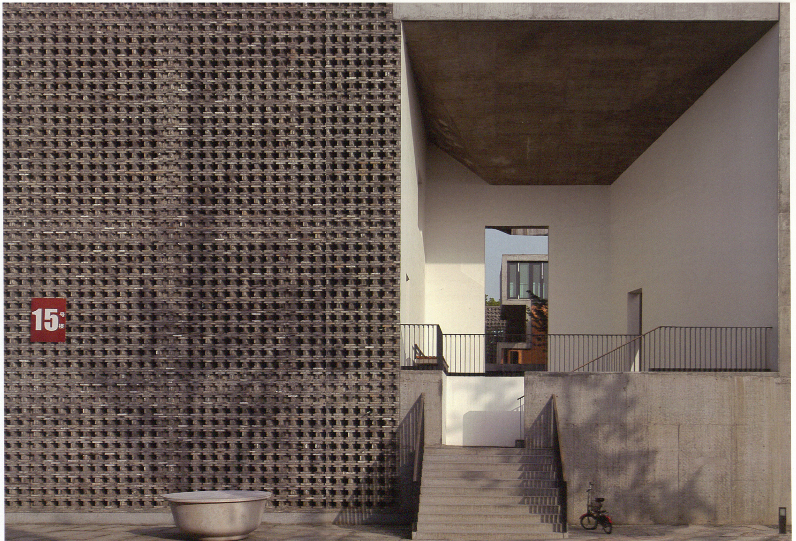
Imagen del edificio 15, aulario del Departamento de Arquitectura. El aparejo de piezas cerámicas en celosía permite una entrada de luz controlada y ventilación en el interior del edificio. Image of building number 15, workshops and classrooms of the Architectural Department. The bonding of clay pieces forming a lattice allows for a controlled entry of light and ventilation in the inside of the building.
