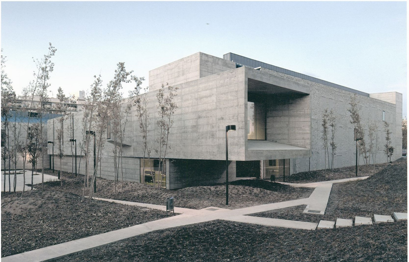
Cuerpo volado de la nueva nave y recorridos quebrados de la parcela. Projecting body of the new warehouse and crooked ways of the plot.
