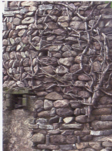
El antiguo pueblo de Long Men, junto a Hangzhou. Uso tradicional de la mampostería mixta, prácticamente sin mortero. The old village of Long Men, by Hangzhou. Traditional use of mix masonry, with hardly any mortar.
