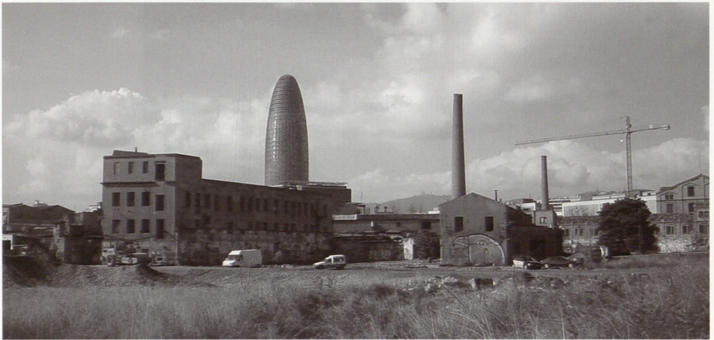
Las abandonadas naves de Can Framis antes de la intervención. Dos de ellas serían conservadas y otra tercera sería demolida y sustituida por una nueva. The abandoned Can Framis warehouses before the intervention. Two of them would be kept and another third one would be demolished and replaced by a new warehouse.
