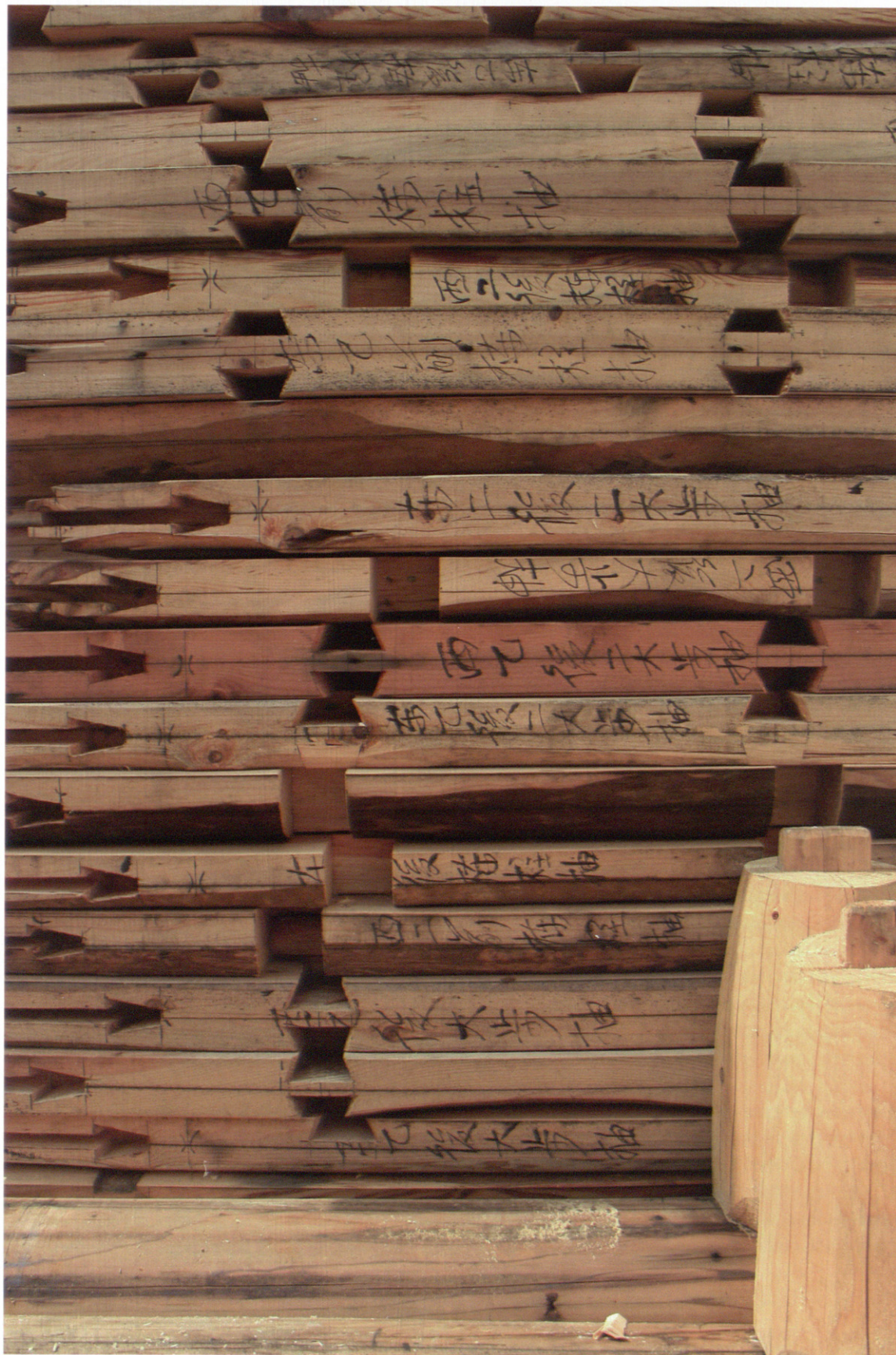
Ensamblados de madera de un sistema constructivo tradicional conocido como Sun & Mao. Wood assemblies from a traditional constructive system called Sun & Mao.
