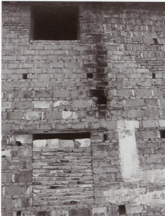
Aparejo de ladrillo irregular en la arquitectura vernácula china. Imagen tomada en Long Men, junto a Hangzhou. Irregular brick bond in the Chinese vernacular architecture. Image taken in Long Men, next to Hangzhou.
