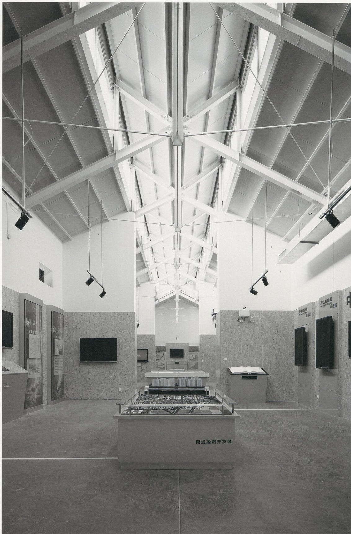
Estructura metálica en equis de la nueva cubierta. X-shaped metal structure of the new roof.
