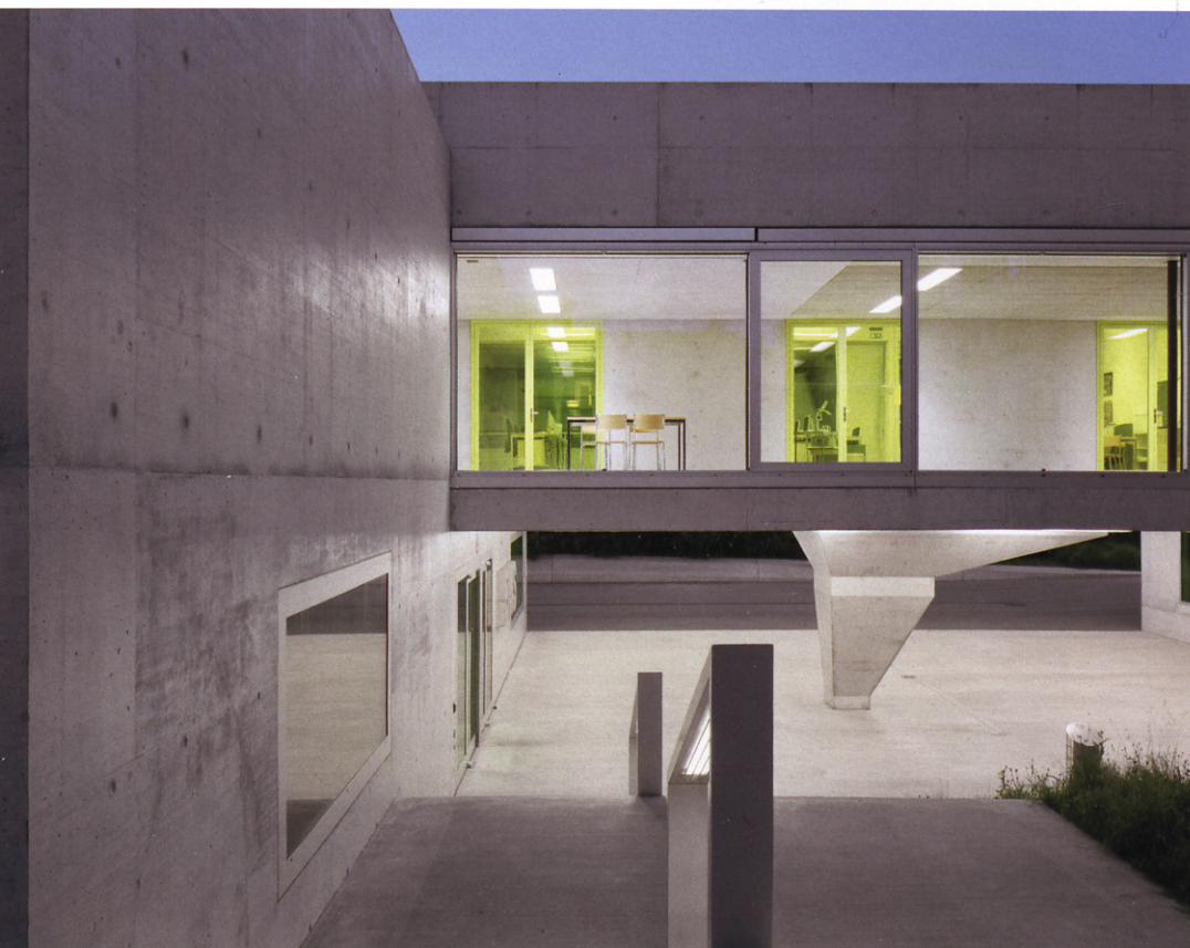
Pasillos, patio y acceso de la ampliación. En la otra página, el pilar recuerda al depósito del proyecto original. Corridors, patio and access of the extension. On the other page, the pillar reminds us of the depot of the original project.
