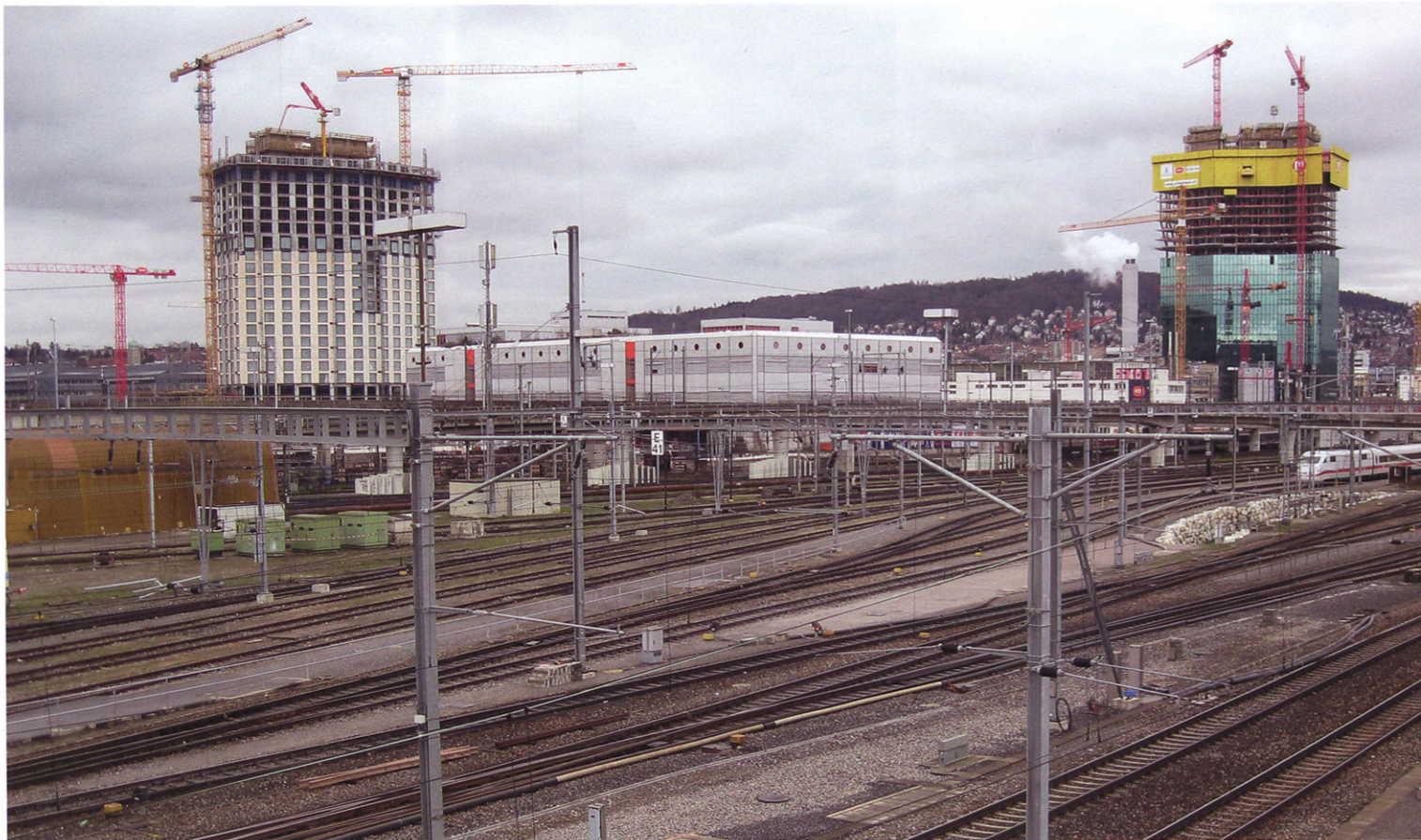
Red de vías y edificios en construcción en Zúrich Oeste. Network of roads and buildings under construction in West-Zürich.
