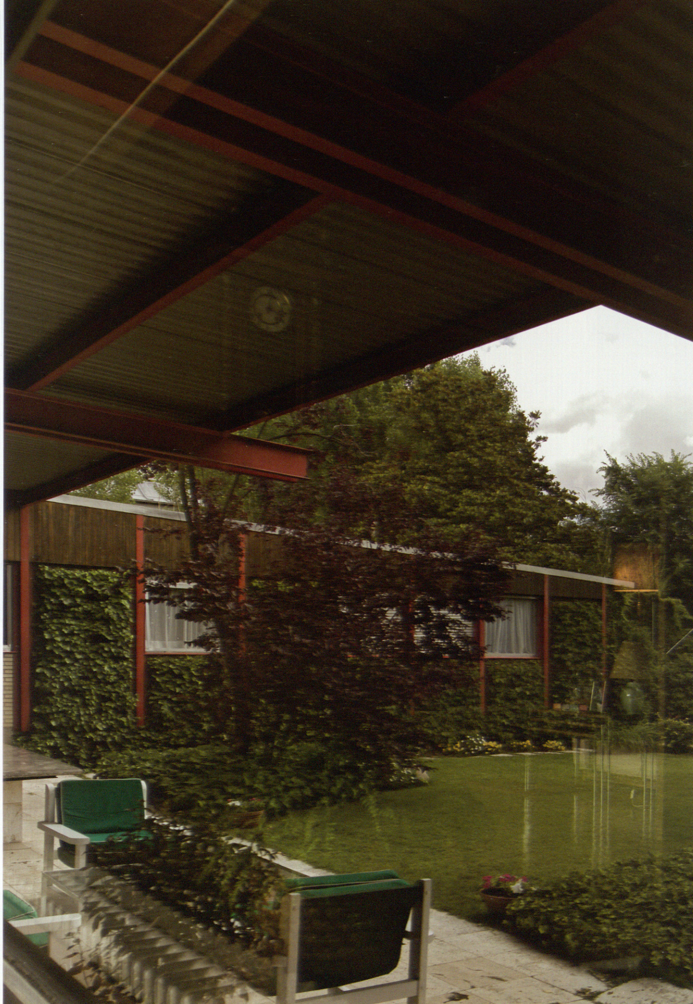
Casa Cabrero en Puerta de Hierro. Francisco de Asís Cabrero, 1961. Ala de habitaciones y jardín dela. Fotografía: Luis Asín. Cabrero House in Puerta de Hierro. Francisco de Asís Cabrero, 1961. Bedrooms wing and front garden, reflected on the enclosure of the living room. Photography: Luis Asín.
