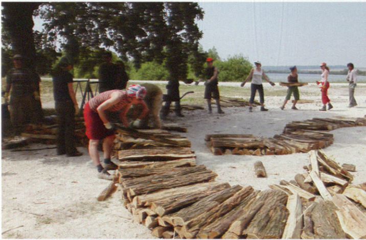
Proceso de la ejecución del proyecto del observatorio en el Parque Natural Balaton Building process of the observatory project in the Balaton National Park
