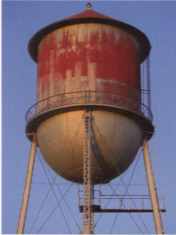
Arriba, referencias. Abajo, proceso de montaje de la torre Above, references. Below, assembly process of the tower
