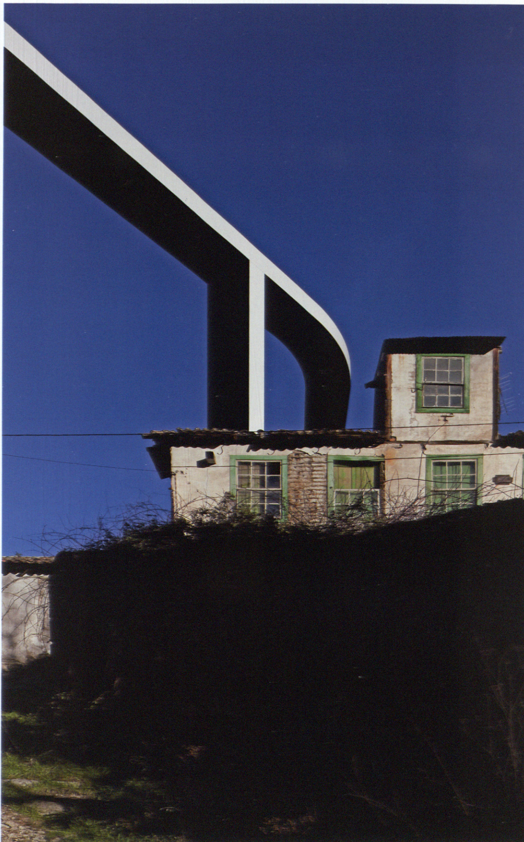
Una curva en tres secciones se adapta a la orografía y facilita la conexión entre el centro y la periferia de Covilhã. El puente, sostenido por cuatro pilares, dos de ellos cilíndricos y los otros dos con base rectangular, es una estructura de acero revestida con planchas de madera. A turn in three sections that adapts to the orography and eases the connection between the centre and the outskirts of Covilhã. The bridge, supported by four pillars, two cylindrical and two with a rectangular base, is a steel structure lined with wood boards.
