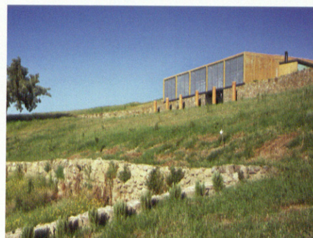
Secuencia de apertura de la celosía. Opening sequence of the latticework
