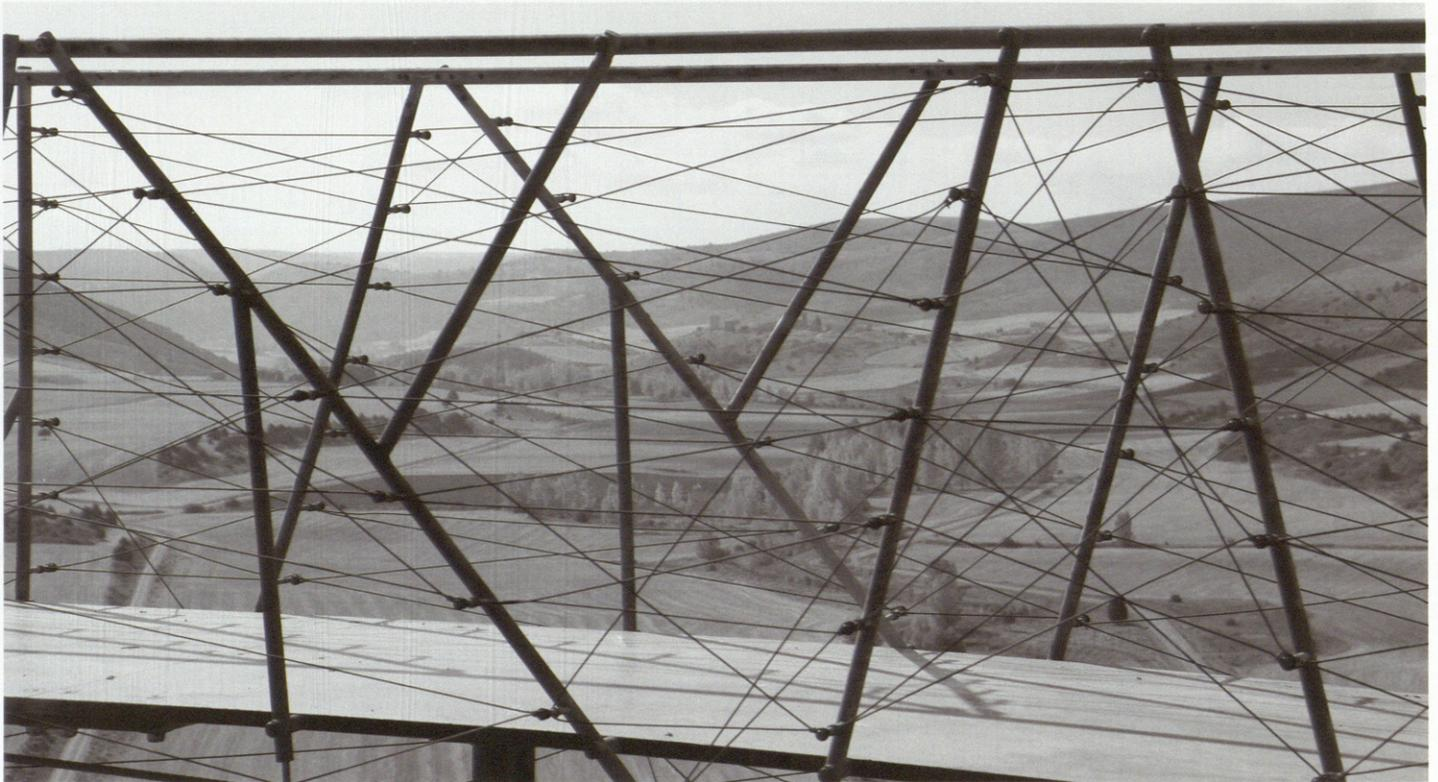
Tras la reconstrucción de la torre se ha realizado un nuevo forjado en planta alta, dos escaleras interiores y la puerta de acceso, todo ello en aluminio, por oposición al espesor y peso de la masa pétreo construida por los árabes. Following the reconstruction of the tower, a new framework was created on the upper floor, two interior stairways and the access door, all in aluminum in order to counteract the thickness and weight of the stone mass constructed by the Arabs.
