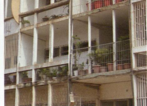
Fachadas y celosías / Fachadas con uso extensivo de *brise-soleils*, ventanas corridas retranqueadas, con celosías y lamas móviles para evitar el sol y permitir la ventilación. Balcones y terrazas para mirar y ser mirado.
