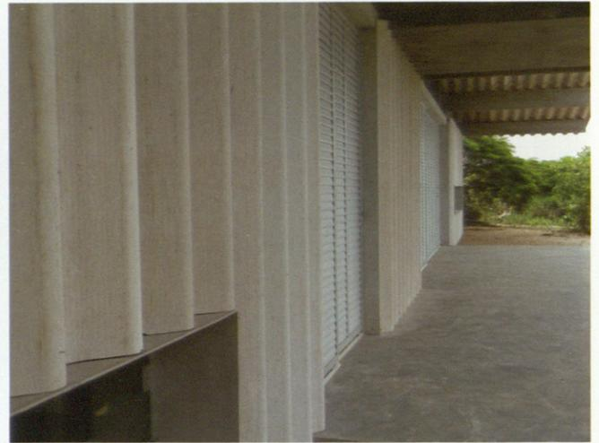
La placa de fibrocemento se deposita sobre la estructura para resolver las aguas de la cubierta o se coloca en vertical para dar forma a los espacios. Grandes carpinterías escamoteables conectan el interior de la casa con la vegetación. The asbestos cement sheeting is installed on top of the structure to deal with water on the roof or are vertically placed to give shape to the spaces. Large hidden carpentry structure connects the interior of the house with the vegetation.
