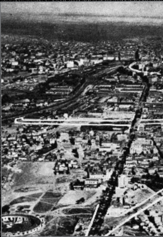
FIG. 04. Líneas de la nueva vía para descongestionar la de Vallecas
