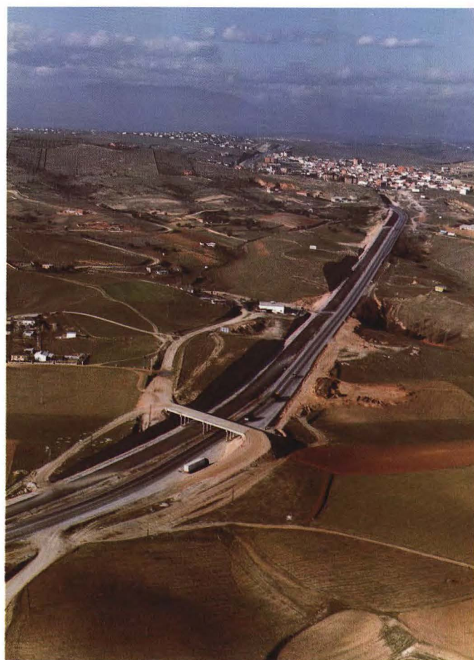
Las autovías de la primera fase se proyectaron con un control de accesos menos estricto, y no siempre evitaban el paso por poblaciones. En la foto se observa la explanación y la obra de fábrica para realizar la segunda calzada de la N-I por San Agustín de Guadalix.
