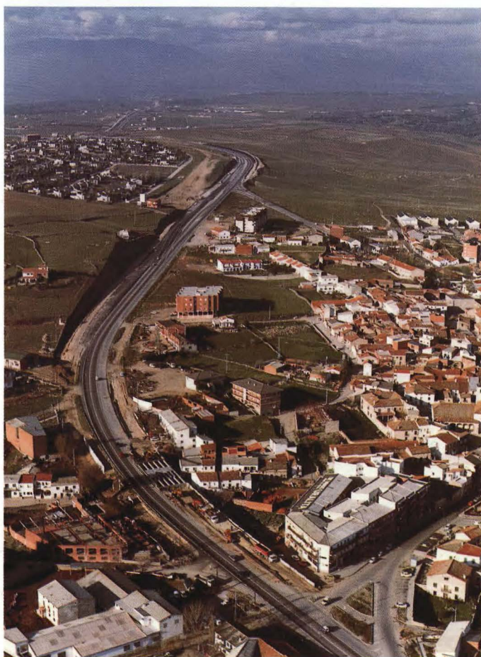
Las autovías de la primera fase se proyectaron con un control de accesos menos estricto, y no siempre evitaban el paso por poblaciones. En la foto se observa la explanación y la obra de fábrica para realizar la segunda calzada de la N-I por San Agustín de Guadalix.
