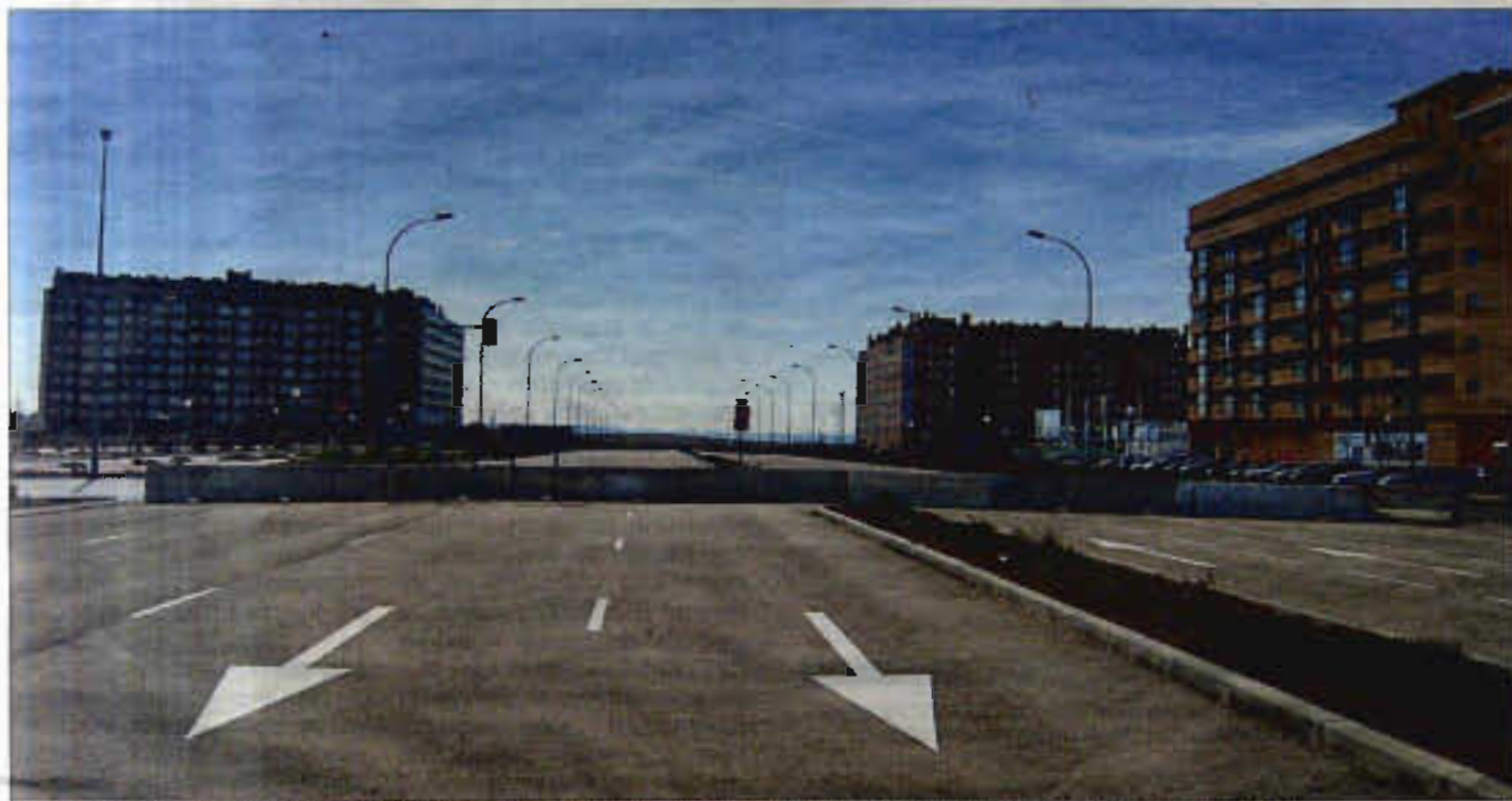
"Una de las grandes avenidas, autovías urbanas, construidas en el extremo sur del PAU Ensanche de Vallecas (Madrid)".
