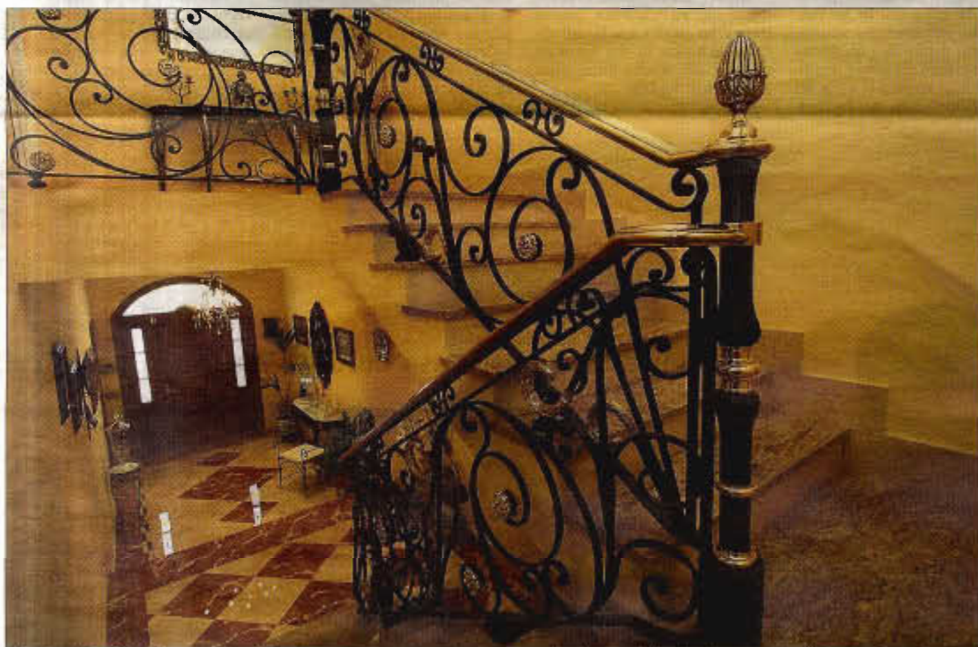
El arte de la forja decorativa. Quedan pocos maestros artesanos que den forma a la forja a la manera tradicional, pieza a pieza y a medida. Utilizan la fragua, en la que calientan las piezas de hierro sobre un yunque mediante el golpeo de un martillo. Mantienen el oficio y trabajan como lo hacían sus bisabuelos hace más de cien años. La forja artesanal sigue teniendo un hueco en la decoración. PÁGINA 7
