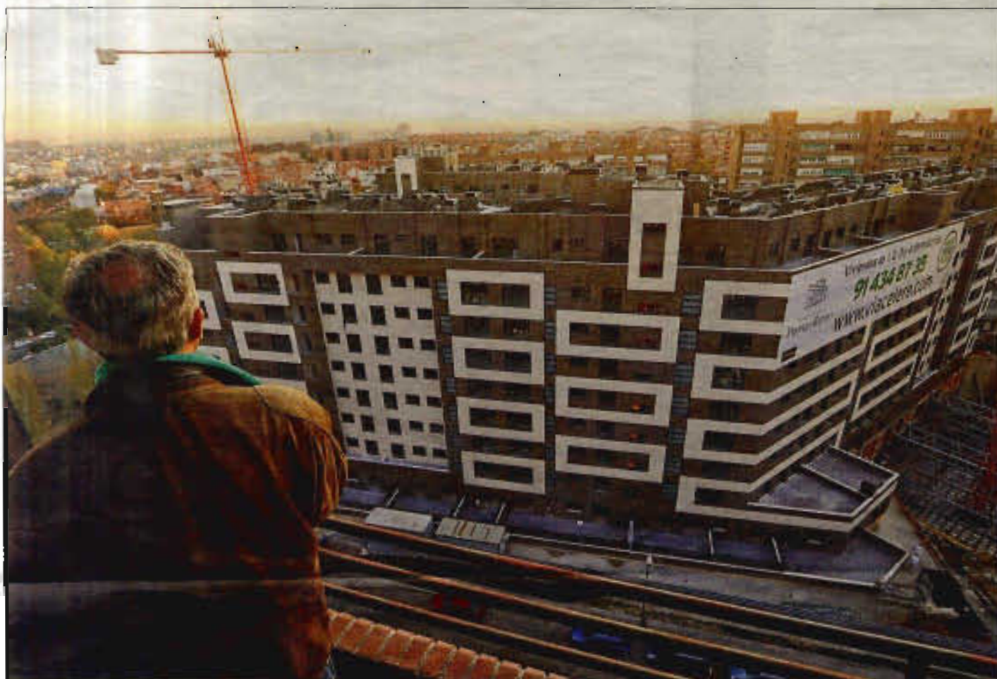
Obras en una promoción de vivienda libre dentro de la almendra central de Madrid. / CARLOS ROSILLO
