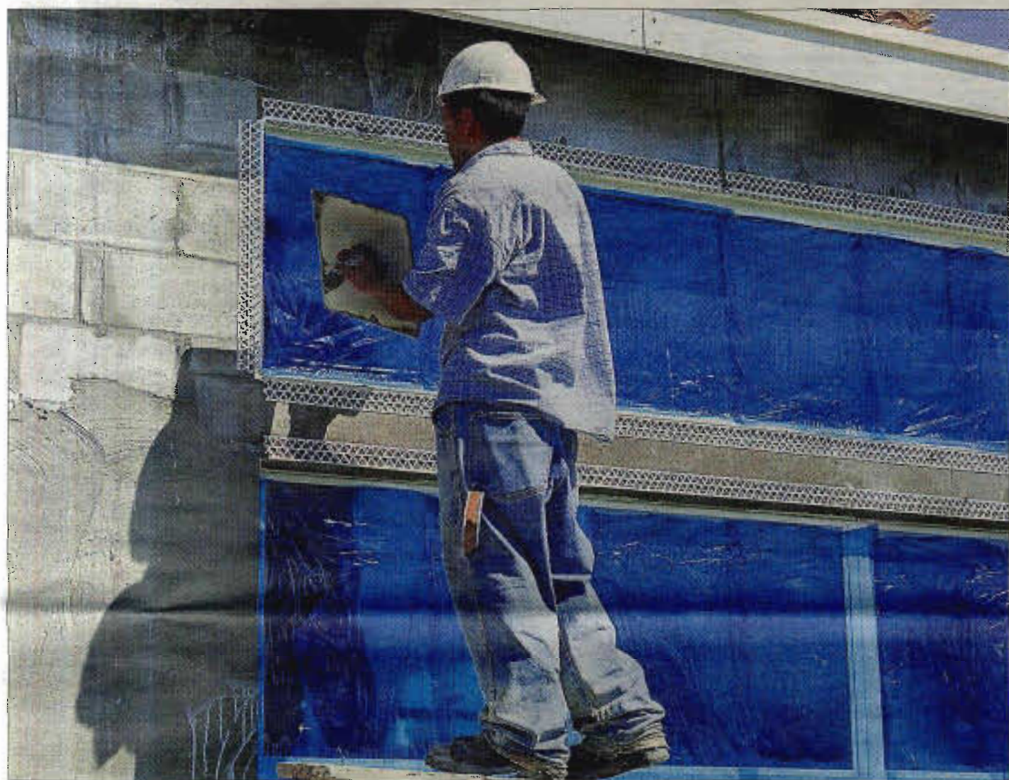
Obras de renovación en una fachada, aprovechando el buen tiempo. / JOEY JACOBSON (GETTY)
