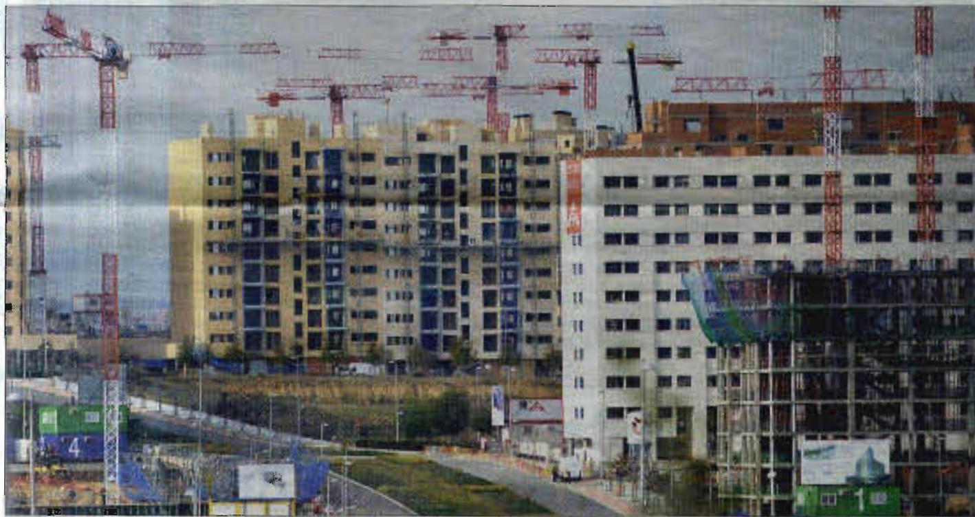
Obras de edificación en Valdebebas a finales del pasado mes de enero. / ERNESTO AVALLO
