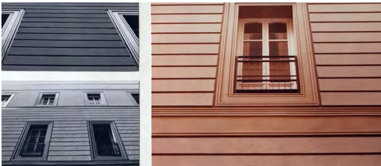
Fig. 311. Fachada del edificio
