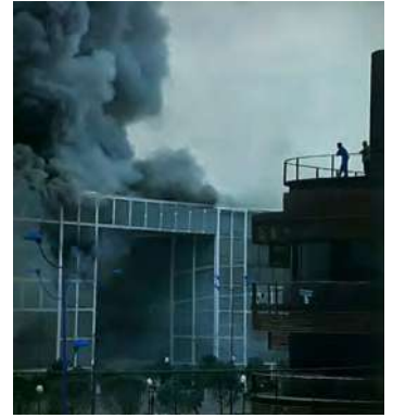
Fig. 396. Imagen del incendio en el Pabellón de los Descubrimientos
