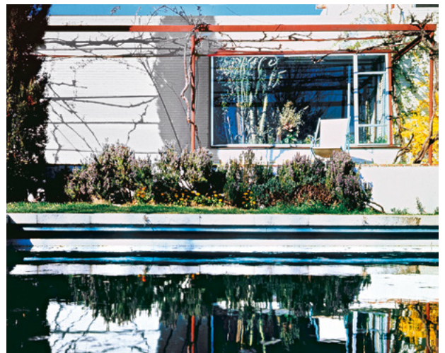
Casa estudio del arquitecto. 1955. 2a ampliación 1966
