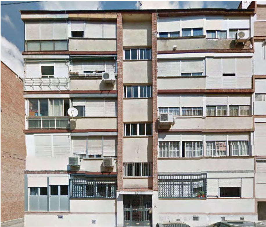
Fachada principal / orientación Suroeste En la imagen se evidencia la disparidad de los cerramientos y la inevitable colocación de los aires acondicionados en fachada a los que hay que dar solución.
