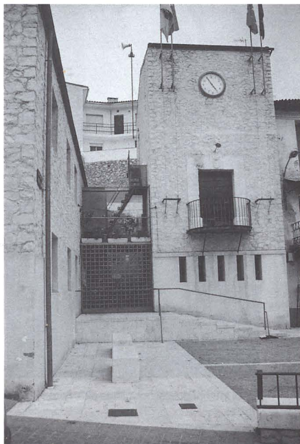
Acceso y plaza. Foto Virginia Torres.
