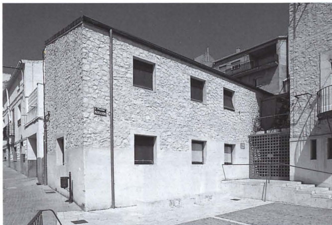
Vista del edificio administrativo.
