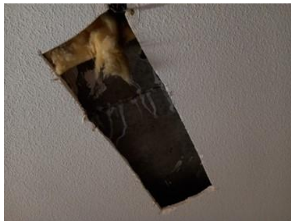
Imagen 32: Techo del salón. Losa de hormigón
