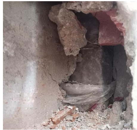
Imagen 7: Detalle de la cata: pilar de fachada con cobertura plástica.
