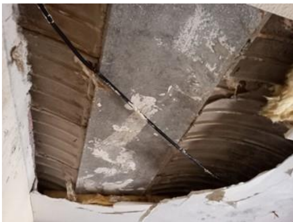
Imagen 31: Techo del dormitorio 1. Losa de hormigón + bovedilla prefabricada de hormigón.
