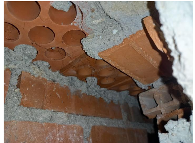
Imagen 27: Ladrillo hueco doble transversal para unión de hojas.
