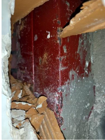
Imagen 3: Detalle de pilar embebido en fachada.
