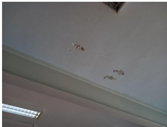
Imagen 16: El espacio intereje entre las vigas de hormigón es de 70 cm..
