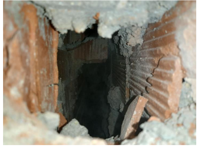
Imagen 25: Detalle de la cata: hoja de fábrica de ladrillo macizo + cámara de aire + hoja de fábrica de ladrillo hueco.
