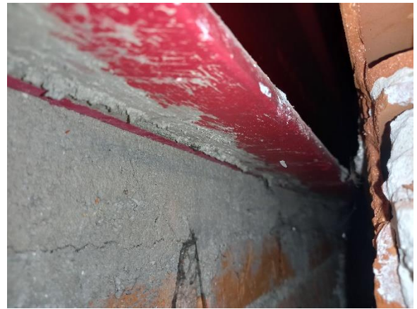
Imagen 10: Viga de fachada
