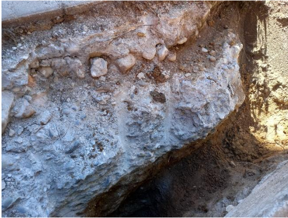
Imagen 21: Zapata aislada de 60 cm de profundidad
