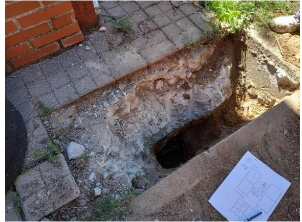
Imagen 22: Cata de cimentación
