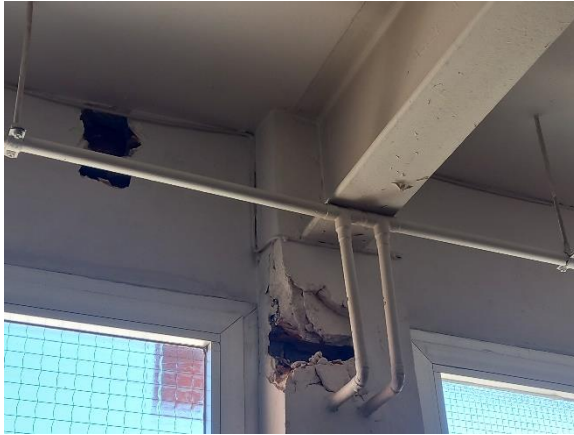
Imagen 12: Los pilares interiores mantienen su dimensión (UPN 110)
