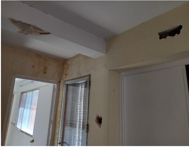
Imagen 24: Inspección de viga y fachada en el cambio de dirección..
