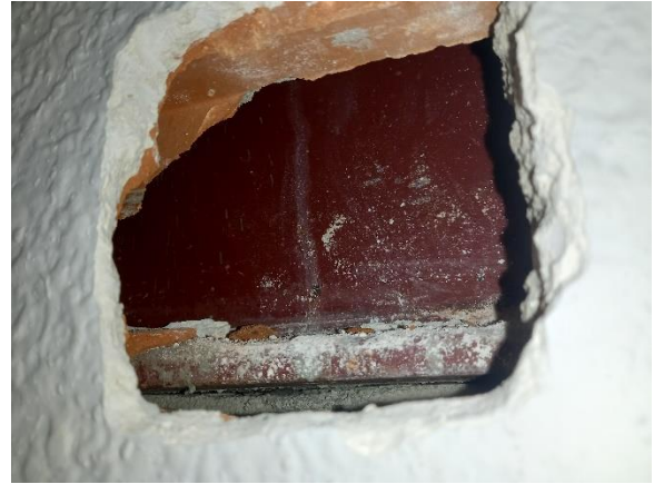
Imagen 13: Detalle de la cata: pilar de fachada con cobertura plástica.
