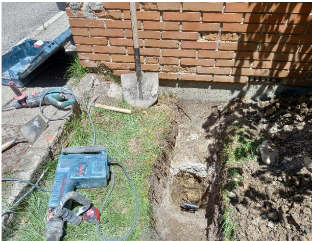
Imagen 26: Calicata de cimentación.
