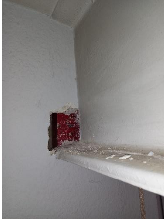
Imagen 9: Cata para comprobar el encuentro de la viga y el pilar
