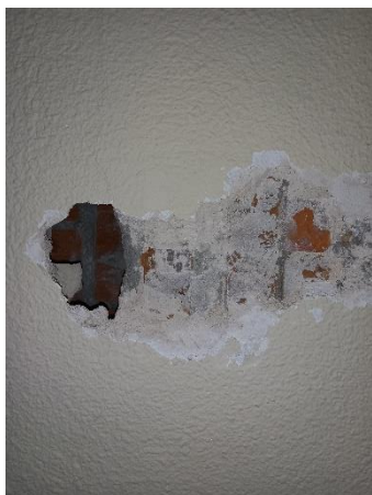
Imagen 15: Se observa bovedilla cerámica
