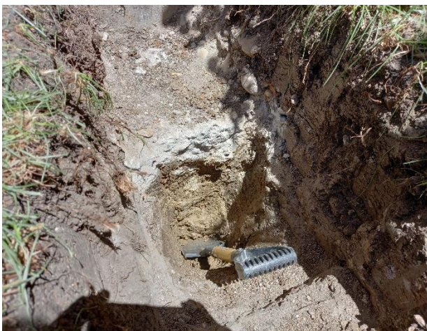
Imagen 28: La zapata corrida tiene 60 cm de profundidad.
