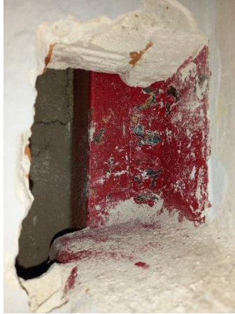
Imagen 6: Los pilares interiores mantienen su dimensión (UPN 110)
