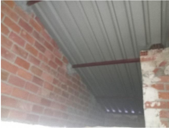
Imagen 18: Cubierta de chapa grecada de acero
