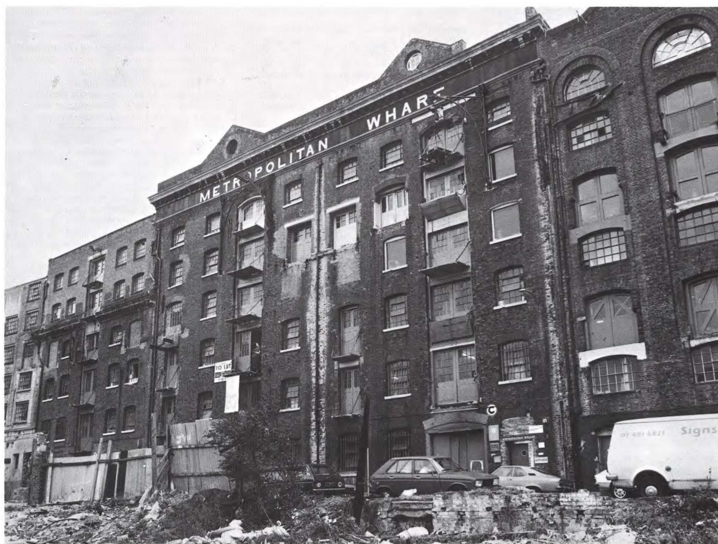
Esta zona está siendo derribada y utilizada, o sea, reedificada: se construyen apartamentos de lujo y oficinas. Muelles abandonados en Wapping en los diques de Londres.
