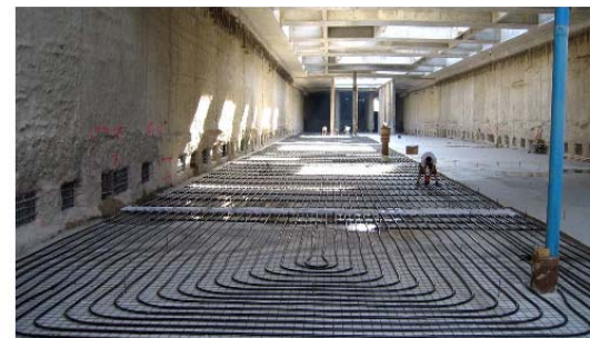
Ejecución de un tramo de losa termoactiva, sistema ENERCRET.
