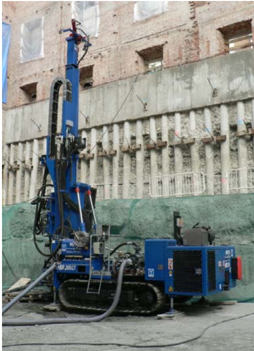
Equipo perforador sondeos geotérmicos
