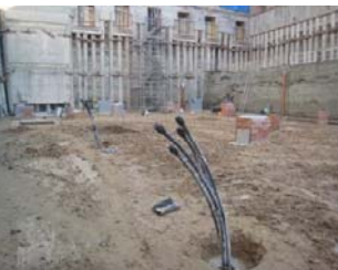
Sondeo geotérmico finalizado
