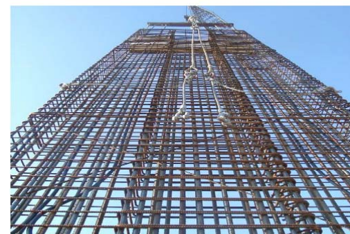
Ejecución de un tramo de muro pantalla termoactivo, sistema ENERCRET.
