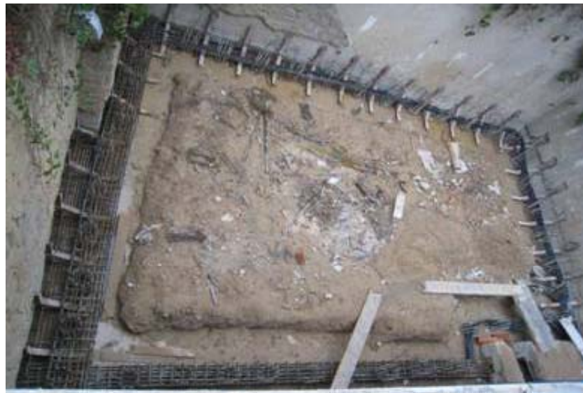
Proceso de ejecución del vaso termoactivo
