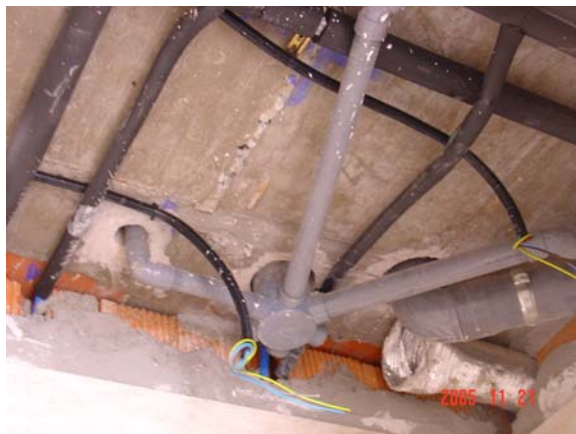
Instalación de saneamiento de un cuarto de baño
