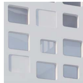
Fachada exterior de hormigón prefabricado
