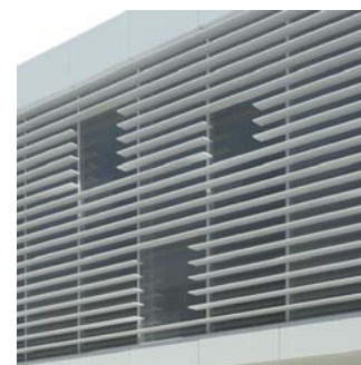
Celosía sobre fachada acristalada sur del patio
