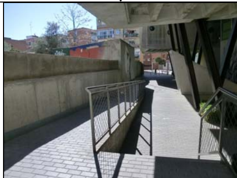
Círculo 1: Rampa en el edificio del Instituto de la mujer:
