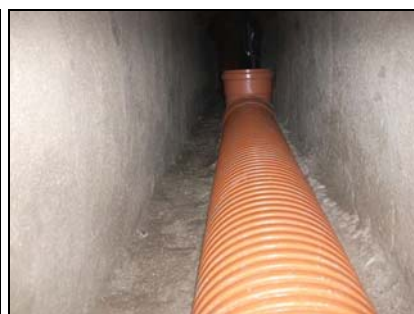
Fotos de resolución de capilaridades mediante perforaciones y reforma de galerías de saneamiento.
