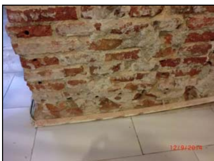
Fotos de resolución de capilaridades mediante perforaciones y reforma de galerías de saneamiento.
