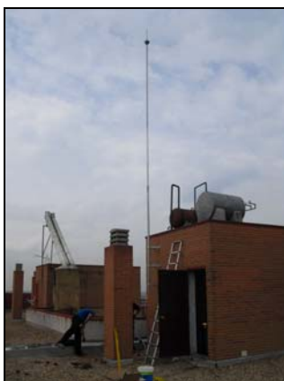
Imagen de un edificio con pararrayos.
