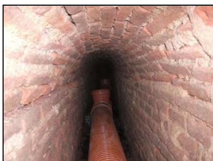
Fotos de resolución de capilaridades mediante perforaciones y reforma de galerías de saneamiento.
