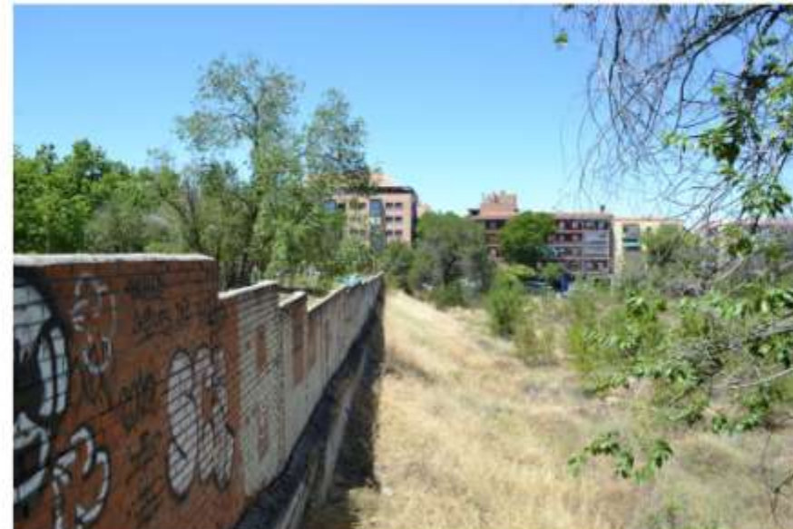
Talud en el área de intervención
