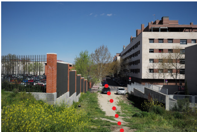
Vial inacabado Paseo de la Estación y Calle. Carabanchel
