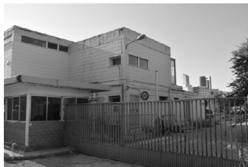
Estado actual del ámbito de las oficinas
