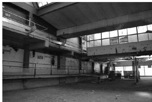
Espacio actual de la nave principal
