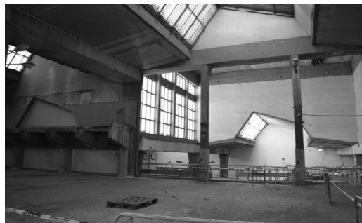
Espacio donde se colocarán los prefabricados
