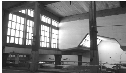
Estado original de la nave industrial
