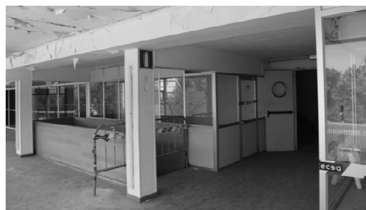
Interior de las oficinas en la actualidad
