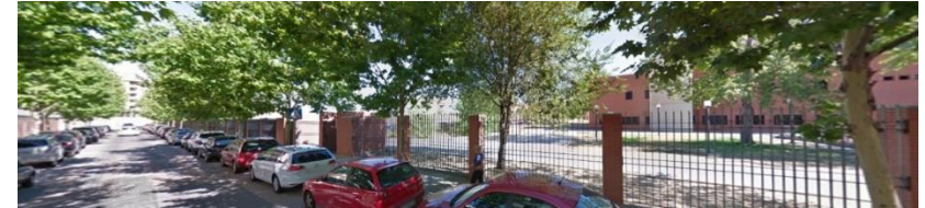
Vista desde la calle Carabanchel del edificio Ortega y Gasset.
