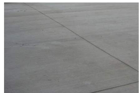
CONTINUO DE HORMIGÓN IMPRESO
