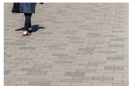
ADOQUINADO DE PIEZAS DE HORMIGÓN
