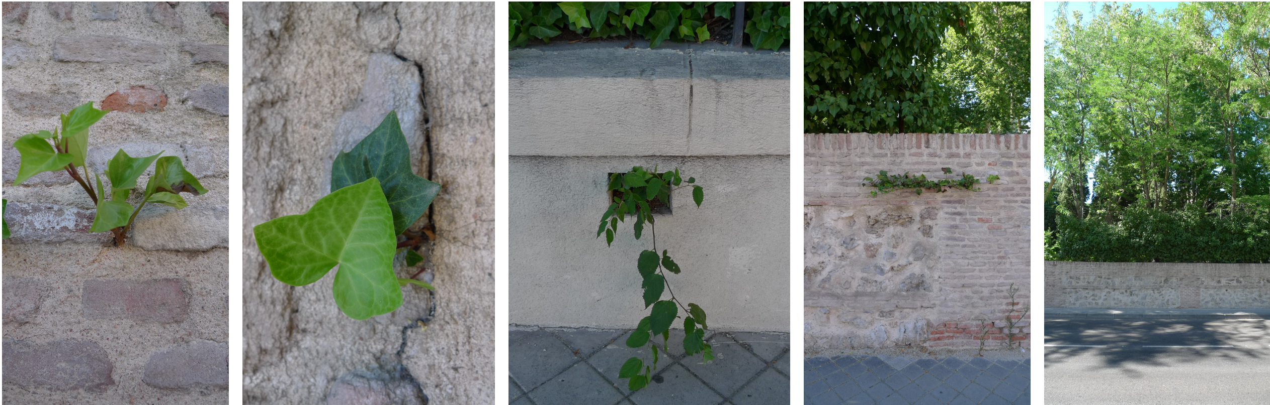
fotografías del estado actual de la tapia de El Capricho con la vegetación traspasando los muros de piedra
