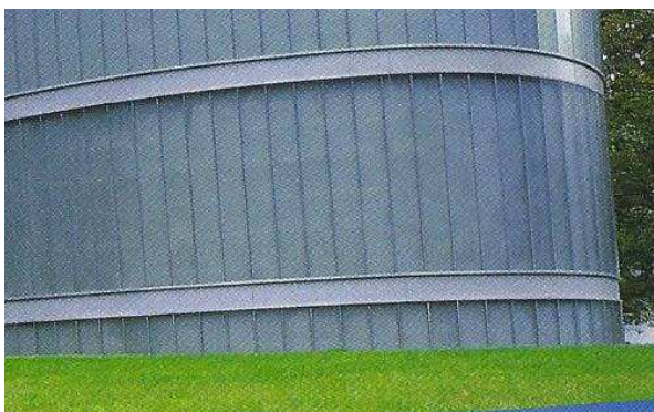
Ejemplo del empleo del u-glass adaptado a formas curvas.
