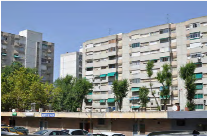
BLOQUE LINEAL. ESTADO ACTUAL
